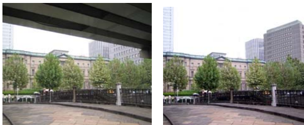
写真-4(左)常盤橋の現状写真(右)常盤橋の高架を撤去したイメージ
