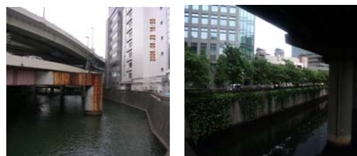
写真-2(左)川沿いの歩けない箇所 (右)川沿いに歩ける箇所
