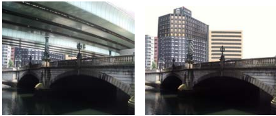
写真-3 (左)日本橋の現状写真(右)日本橋の高架を撤去したイメージ
