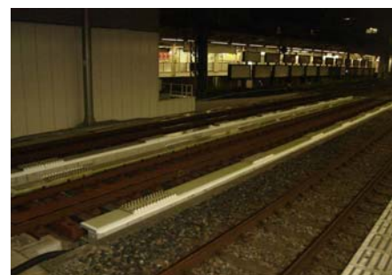
写真-2. 試験に使用した軌道桁
