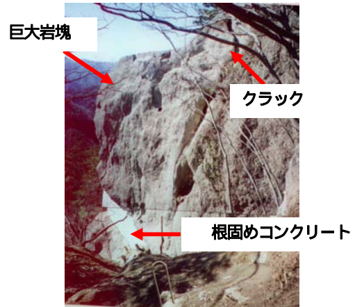
図 - 1 施工後の岩盤斜面
