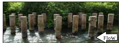
図-1 北上川水系砂鉄川の杭水制（千鳥配列）
