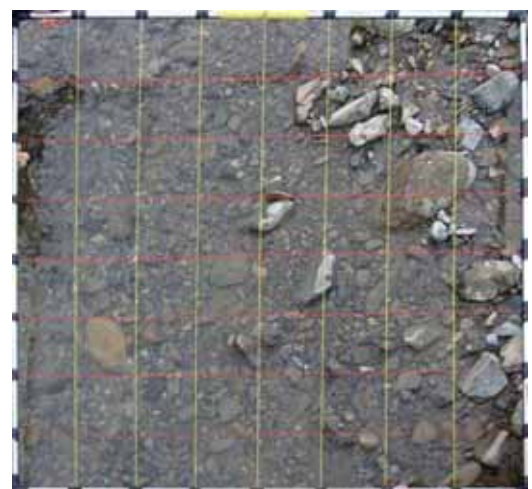
写真-2 No.30 表層写真(外岸部)
