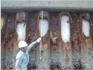
写真-5 腐食した護岸
