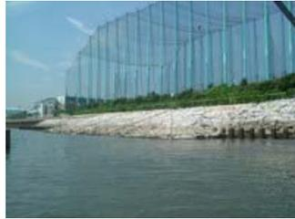
写真-6 緩傾斜護岸
