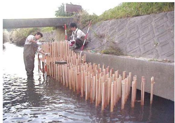
図-3 杭挿入作業時の様子
