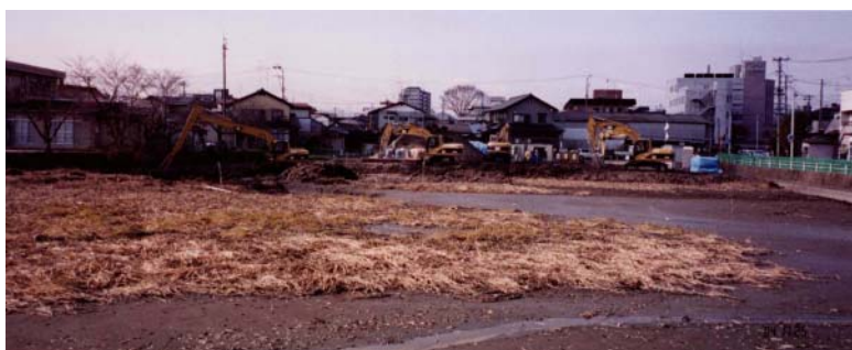
写真-1 ため池改良工事全景
