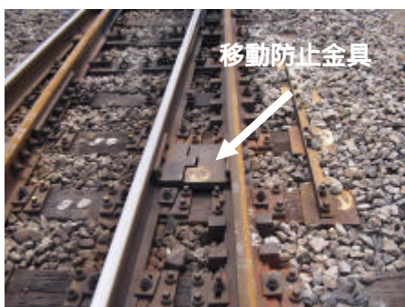
Pic.1:移動防止金具及びふく進防止対策
