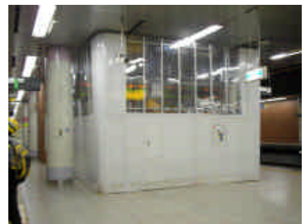
写真-3 仮囲い設置状況
