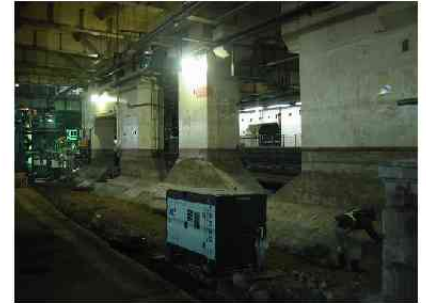
図2．南口駅舎橋脚施工前
