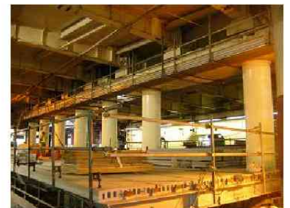
図3．南口駅舎橋脚施工後
