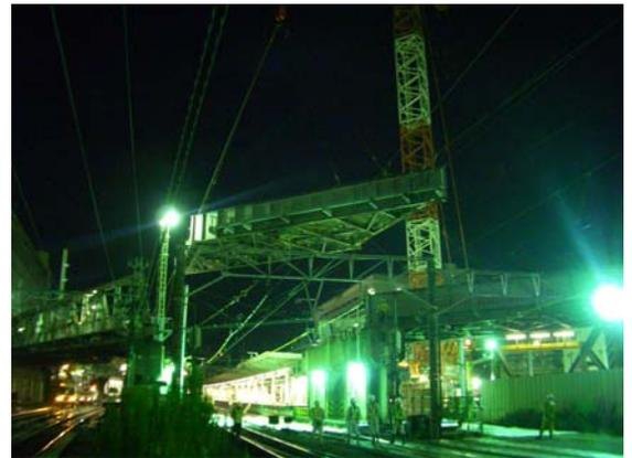
写真-2 G1 桁撤去
