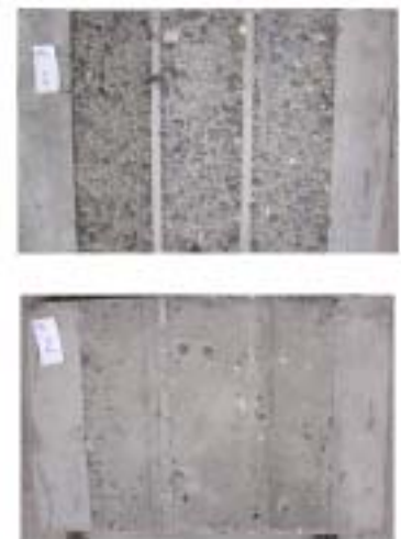
写真-1 ウォータージェット処理面 (上: 処理 A、下: 処理 B)
