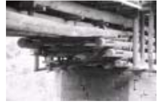
写真-4 片持ち梁部の部材構成
