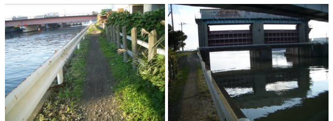
写真-1 河口河岸と真間川水門
