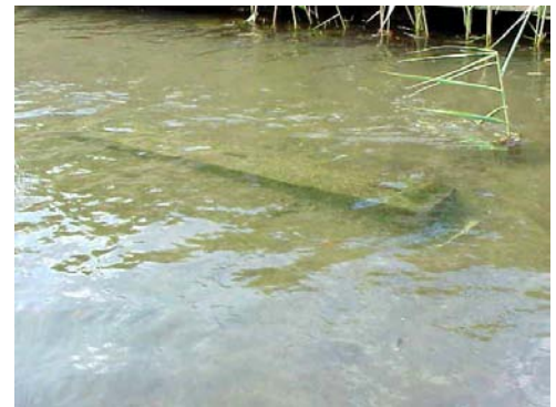
図-4 水制構造物
