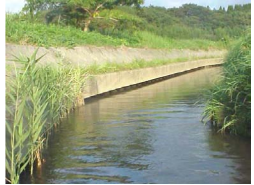
図-3 植生を施工した湾曲部
