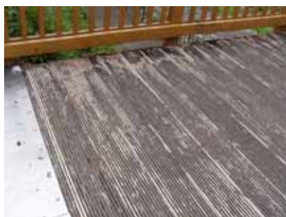
写真-5 ささら橋床版(10/16)
