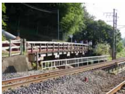
写真-1 子持橋全景
