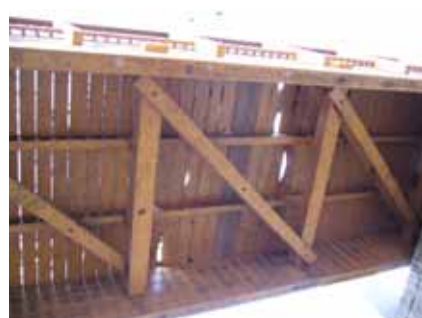
写真-6 ささら橋床版(12/10)
