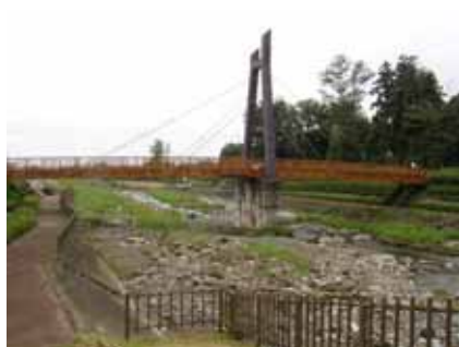
写真-4 ささら橋全景
