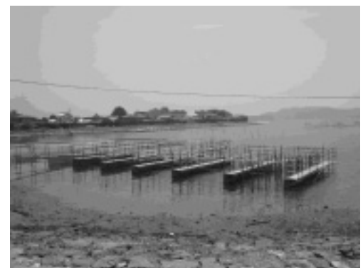
図 - 2 実験設備全景
