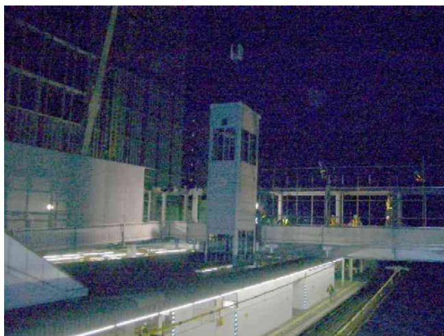
図-6 エレベーター一体搬入
