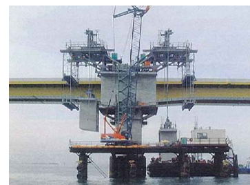
写真-4 ノーズ架設状況
