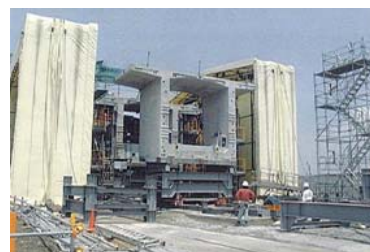
写真-2 ショートラインによるセグメント製作
