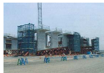
写真-3 ロングラインによるセグメント製作
