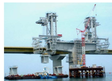
写真-5 特殊ノーズ架設状況
