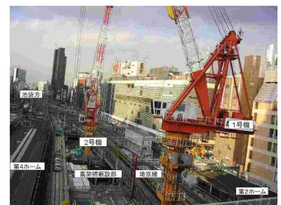
写真 2. タワークレーン設置状況
