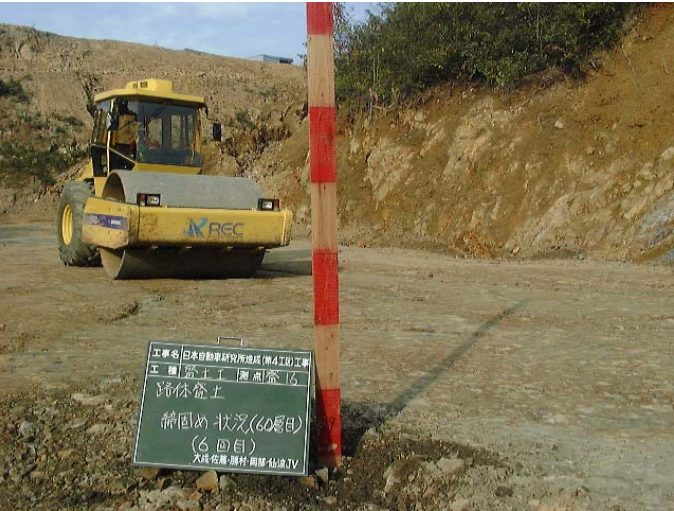
写真-1 締固め状況写真
