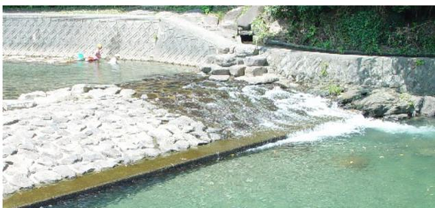
写真 1 河通川にある石張り越流面を有する床固工
