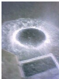
Figure 1: 人孔からの溢水状況 (H15.5.8 新大阪駅付近)
