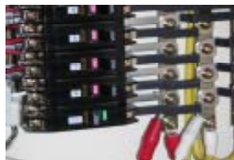
写真3 分電盤設置風景
