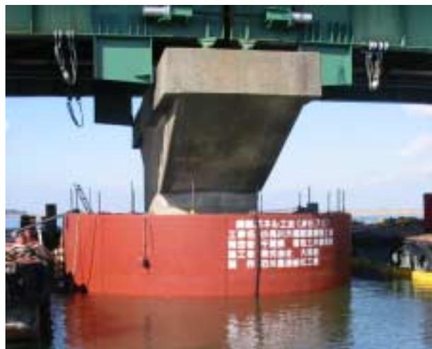
写真 - 1 小見川大橋耐震補強工事(H14)
