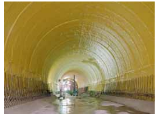
図-4 防水シート敷設完了状況
