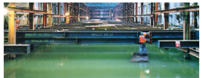
写真-1 水張り足場工法施工状況
