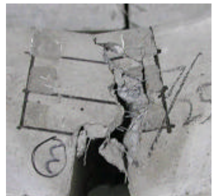
写真-1 ST1.5%のひび割れ状況
