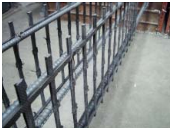
写真-1 FRP 格子筋のせん断補強筋としての配筋
