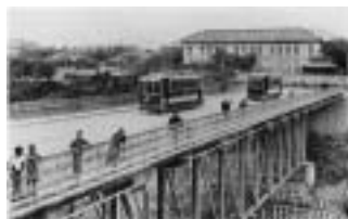
写真 - 4 御茶ノ水橋（上路橋）
