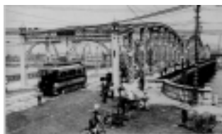
写真 - 5 両国橋（下路橋）
