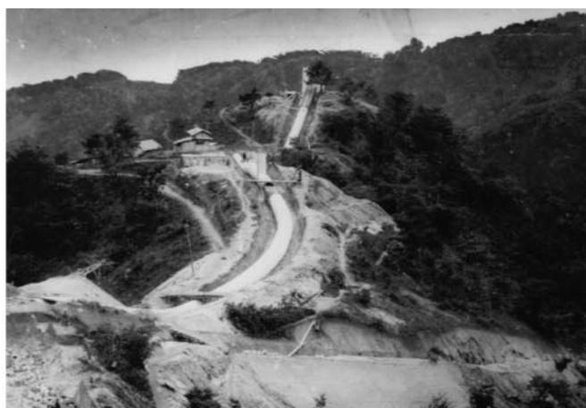
写真-1 石岡第一発電所RCサイホン建設工事
