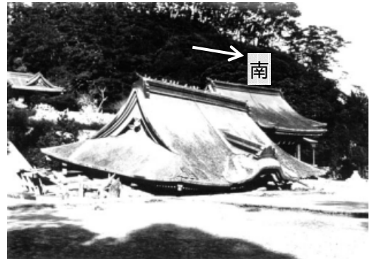
図 1 鎌倉八幡宮舞殿被害写真（南西角） 2) （1923 年関東大震災）
