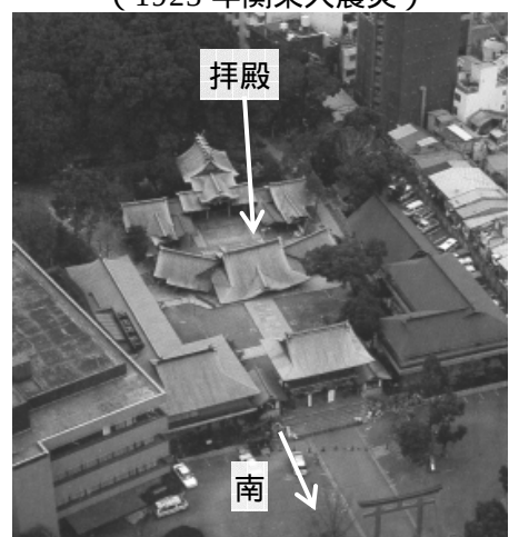
図 3 生田神社拝殿被害写真（南西上空） 4) （1995 年兵庫県南部地震）
