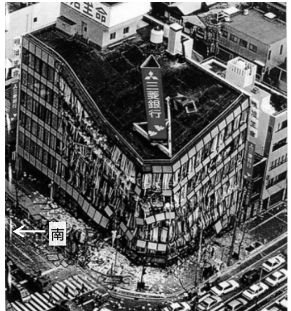
図4 三菱銀行兵庫支店(北東面) 5) (1995年兵庫県南部地震)
