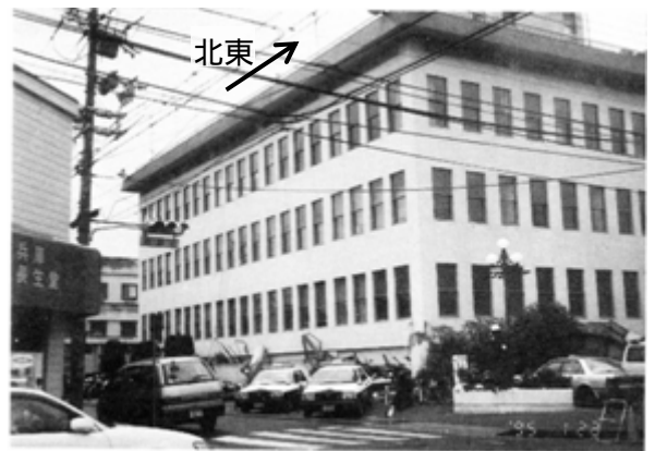
図5 兵庫警察署(東角) 6) (1995年兵庫県南部地震)
