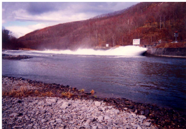
写真 1 余水放流状況
