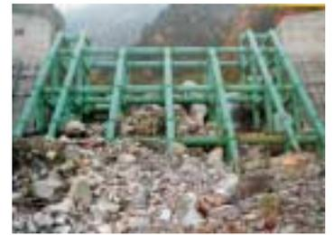
写真-1 鋼製透過型砂防ダム
