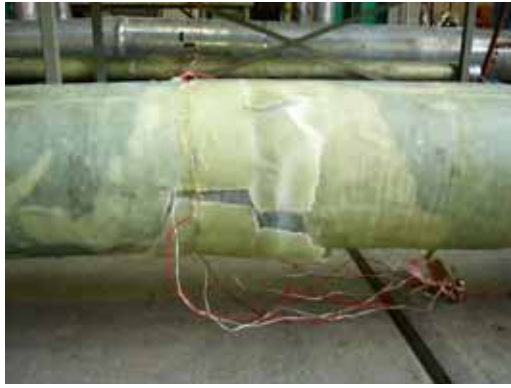
写真-1 座屈破壊
