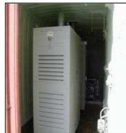
写真-2: マイクロガスタービン発電機
