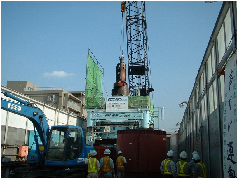
写真-1 施工状況
