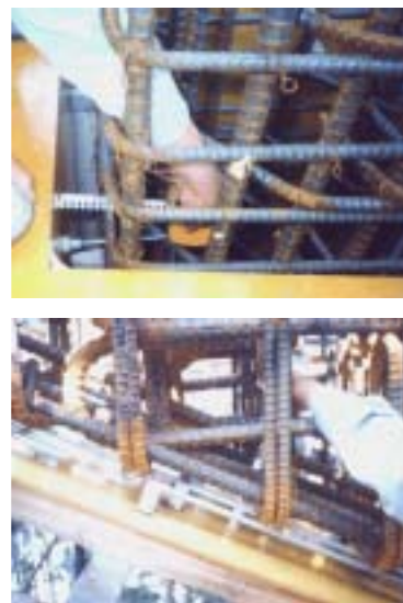
写真-1 かぶり計測の現状
