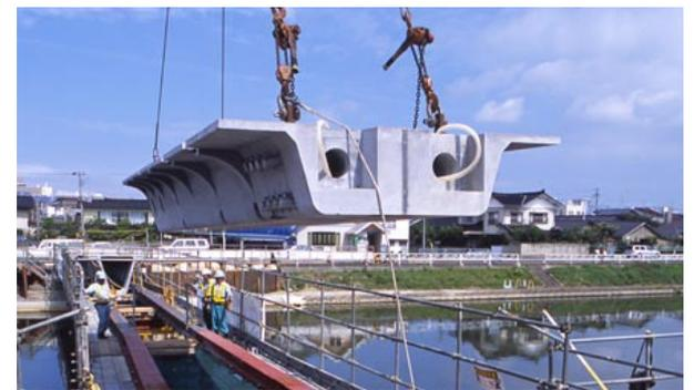
写真-5 端部ブロックの架設
