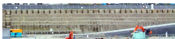
写真 - 1 CRM と CDM による改良法面
