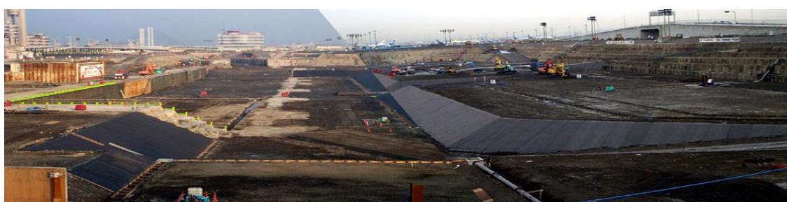
写真 - 2 工事竣工
