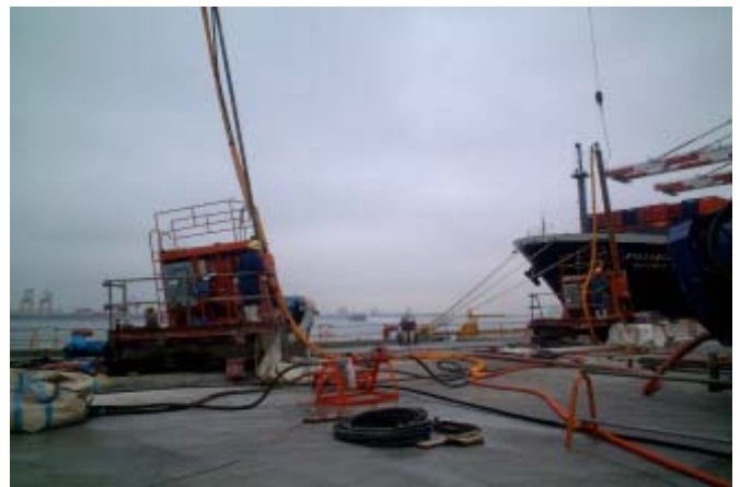
写真-2 斜杭施工状況
