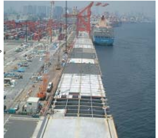
写真-1 現場全景
