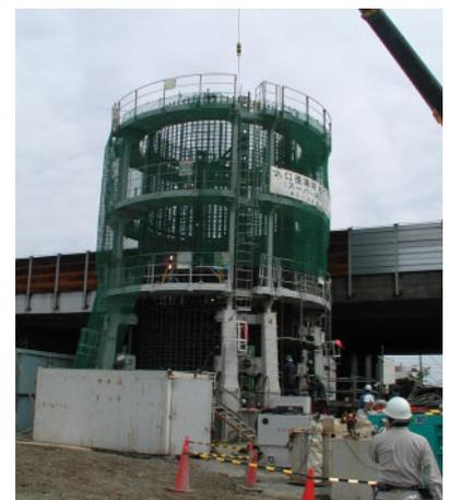
図—7 鉄筋籠沈設状況
