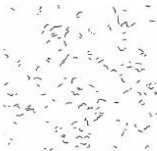
図 1：画像処理により抽出したひび割れ
