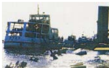
図-1 メリケン波止場岸壁の崩壊
