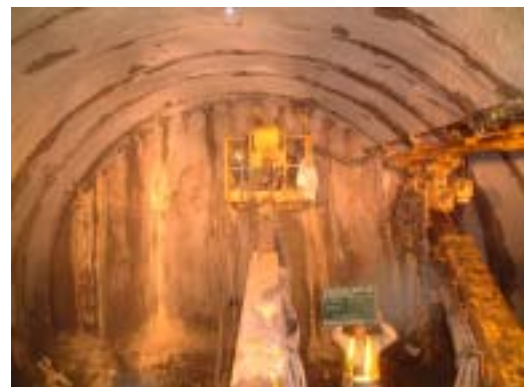
写真-2 長尺先受け工（AGF工）
