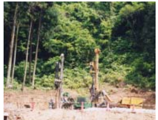
写真-1 薬液注入工
