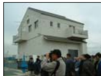
図3 場内の排水機場
