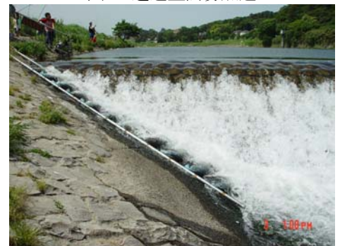
写真-1 設置状況
