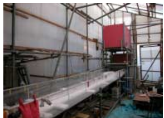
写真 - 1 水路の様子
