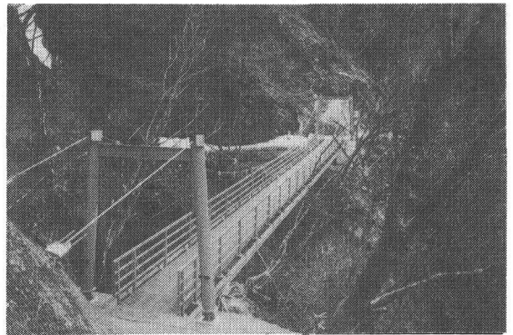
写真-2 吊橋全景
